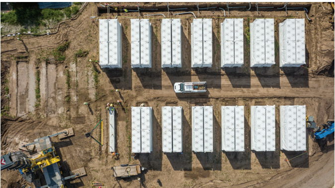
Goleta Energy Storage | Goleta, CA 60 MW BESS project 44 Tesla Megapacks BESS
